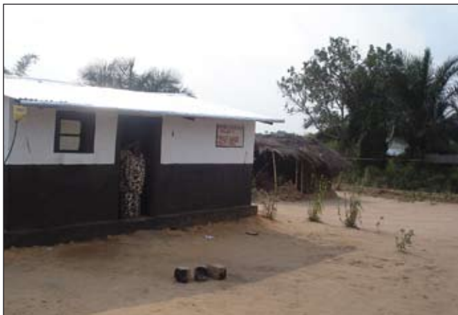
Oud en nieuw naast elkaar. Eindelijk een solide dak boven het hoofd!
